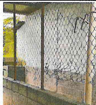
Foto 4: MURO PERIMETRAL LADO IZQUIERDO
