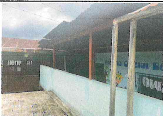
Foto 1: IMPLEMENTACIÓN DE BARANDA DE METAL EN MURO PERIMETRAL (PARTE DE ENFRENTA)
