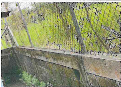
Foto 3: MURO PERIMETRAL DE LA ESCUELA LADO DERECHO
